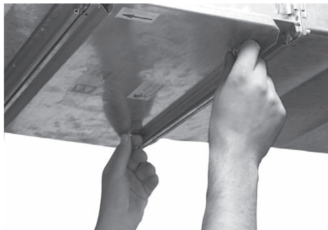
РИСУНОК 4 – ИЗЪЯТИЕ ФИЛЬТРАЦИОННОЙ ВСТАВКИ
